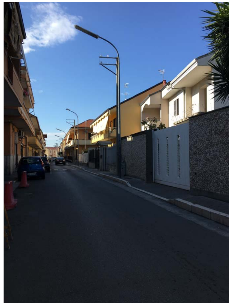
Palo Conico Curvato (h = 8,00 m, sbraccio = 2,30 m, ang. = 20°)
