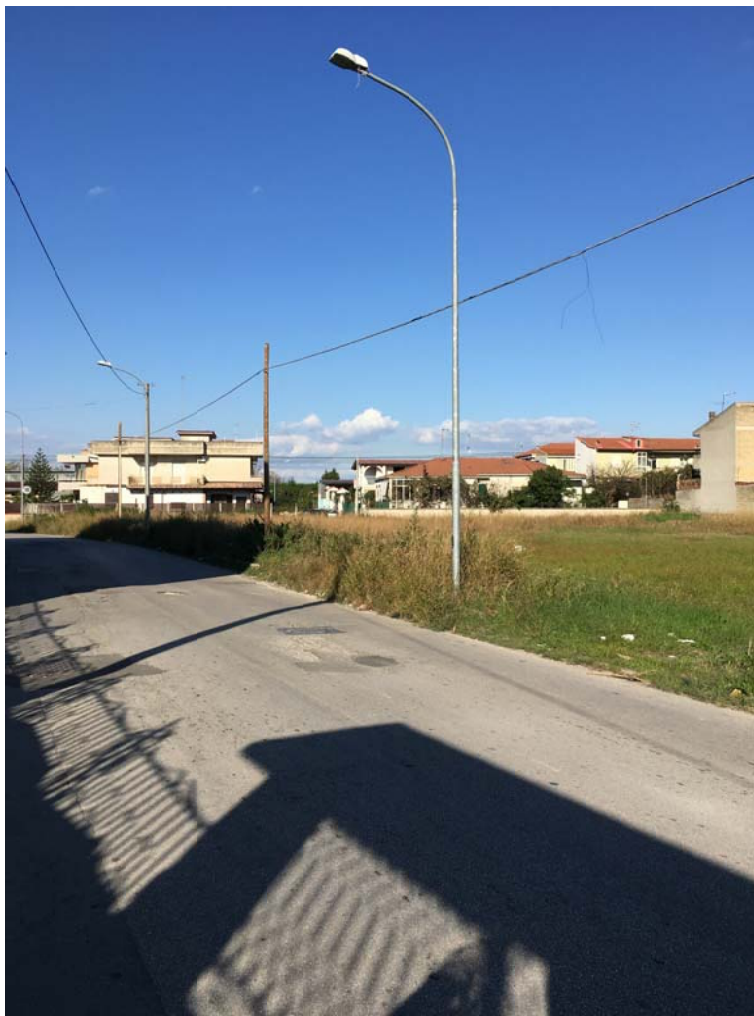
Palo Rastremato Curvato (h = 8,00 m, sbraccio = 2,50 m, ang. = 20°)
